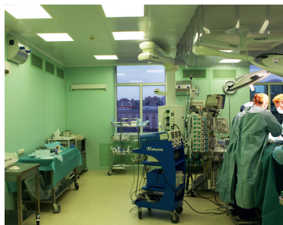
Рис. 18. Пример размещения облучателей «Альфа-02» для создания эффекта «светового котла» в операционной Национального научно-практического центра здоровья детей МЗ РФ, г. Москва
